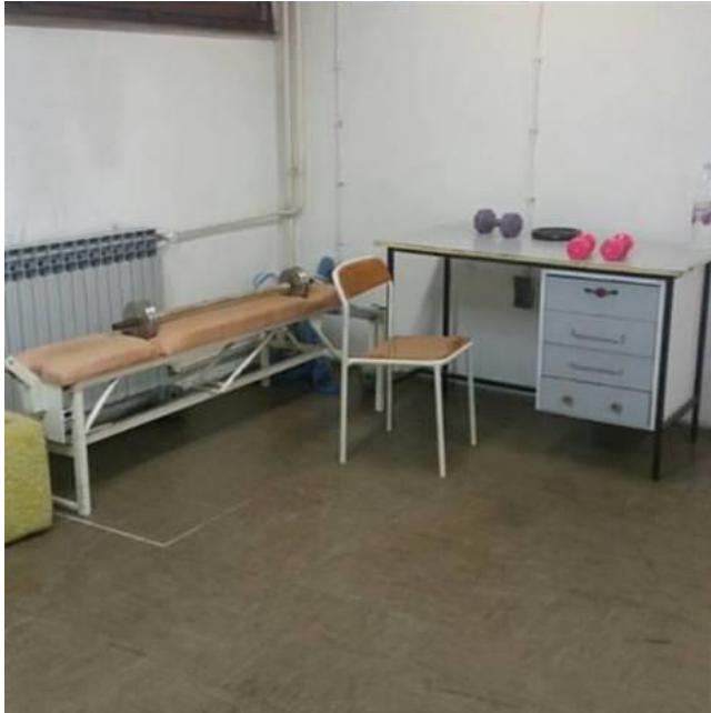
Slika 1. Teretana Doma za odgoj djece i mladeži Zagreb prije obnove
