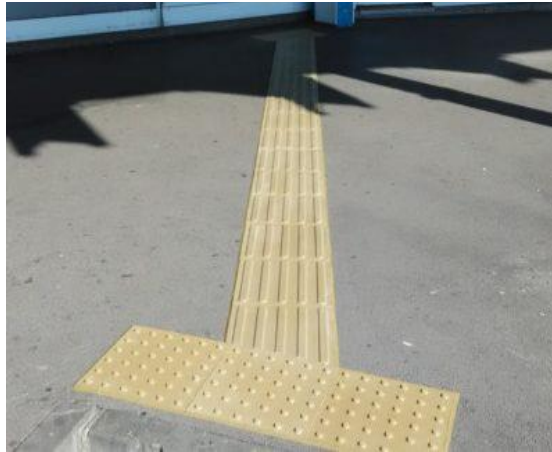
Slika 1. Taktilna linija vodilja i taktilno polje upozorenja
