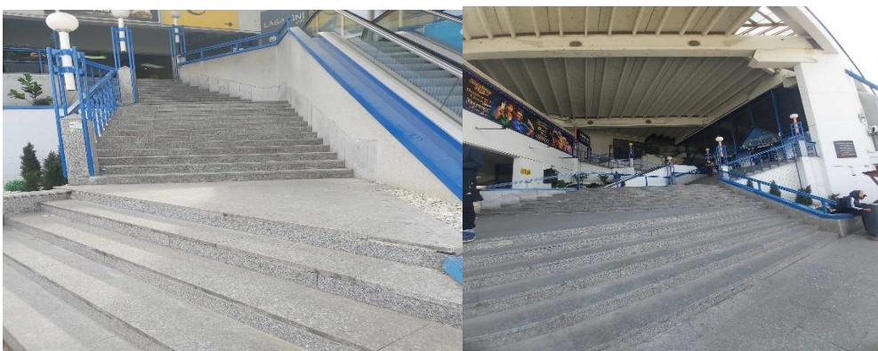
Slika 6. Stube Autobusnog kolodvora Zagreb
