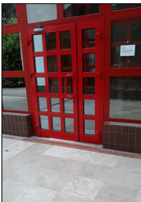
Slika 13. Ulaz u restoran 2 u naselju „Stjepan Radić („Sava“)“ – vidljivo je kako ne postoji otirač, a kvaka je iste boje kao dovratnici i pregrade što joj smanjuje uočljivost
