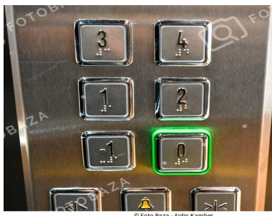
Slika 38. Pristupačne tipke unutar dizala
