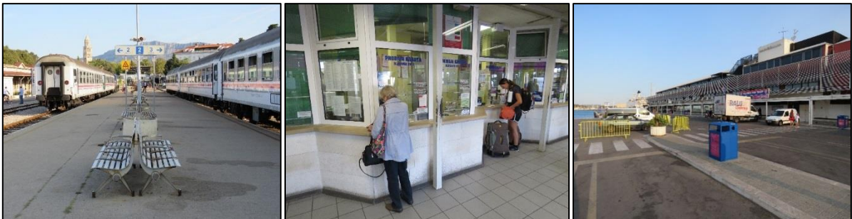
Slika 20, 21 i 22: Slikovni prikaz prostora željezničkog (1) i autobusnog (2) kolodvora te trajektne luke (3) na kojima nema taktilnih crta vodilja i upozorenja (kolovoz, 2017)
