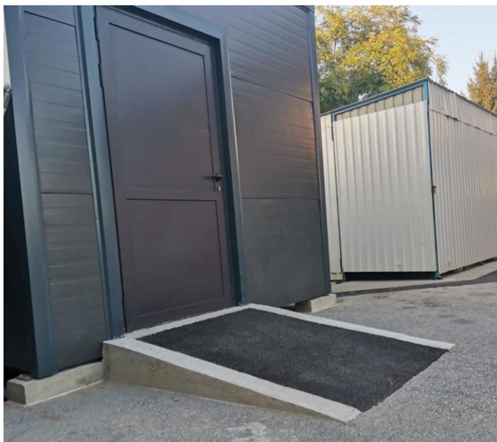
Slika 10. prikazuje nepristupačnu rampu postavljenu na ulaz u javni wc.
