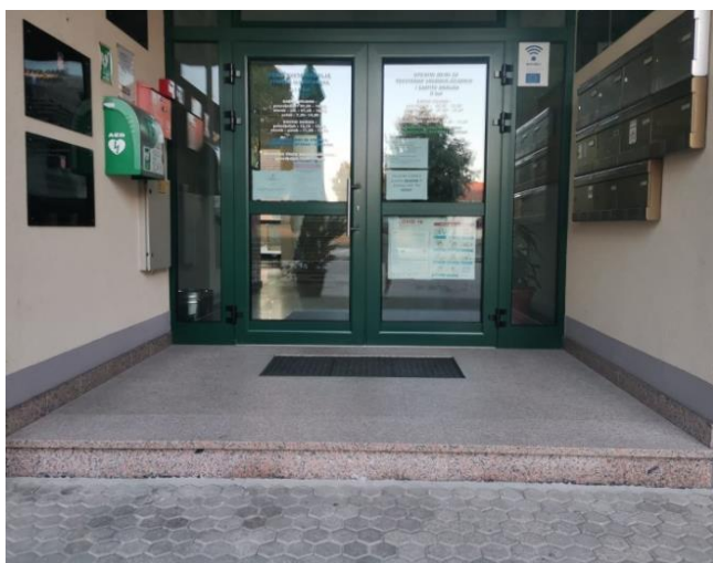
Slika 13. prikazuje stubu na glavnom ulazu u Vijećnicu.
