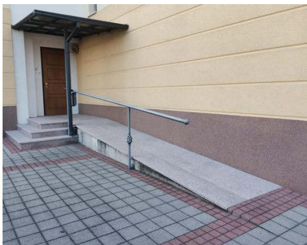
Slika 12. prikazuje rampu koja vodi do alternativnog pristupačnog ulaza u Župnu Crkvu Blaženog Alojzija Stepinca.
