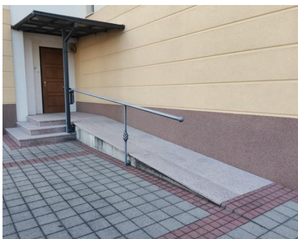
Slika 12. prikazuje rampu koja vodi do alternativnog pristupačnog ulaza u Župnu Crkvu Blaženog Alojzija Stepinca.
