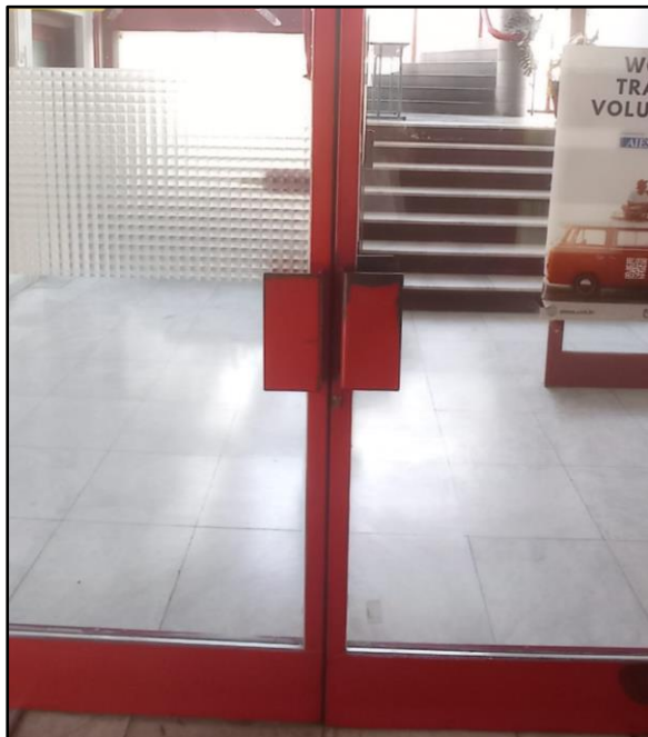
Slika 11. Nepristupačna kvaka u upravi naselja „Stjepan Radić („Sava““
