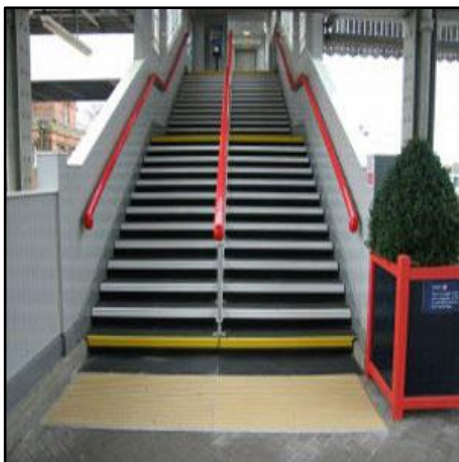
Slika 26. Primjer taktilnog polja upozorenja prije prve stube
