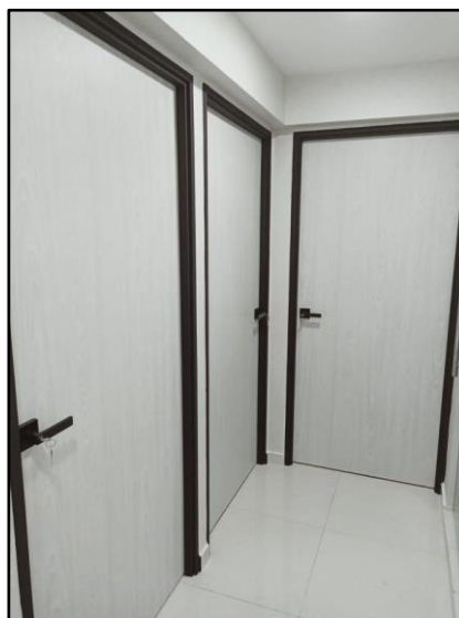
Slika 29. Primjer isticanja bojom – dovratnici u odnosu na zid te kvaka u odnosu na vrata
