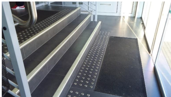
Slika 37. Prikaz pristupačnog stubišta
