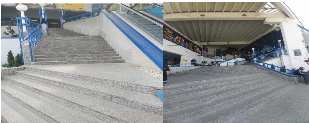
Slika 6. Stube Autobusnog kolodvora Zagreb
