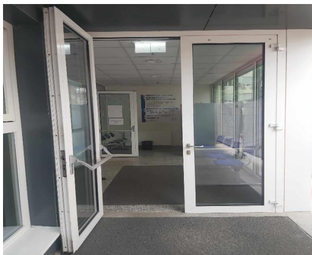
Slika 25. Ulazna vrata i predvorje zgrade Klinike za očne bolesti, KBC Sestre milosrdnice Zagreb
