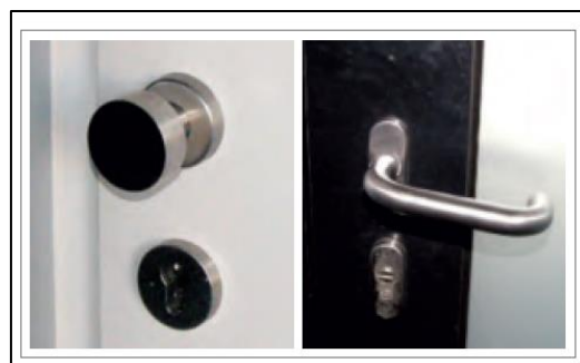
Slika 9: Prikaz nepristupačne (lijevo) i pristupačne (desno) kvake na vratima (Španić, Pavlović, 2012)
